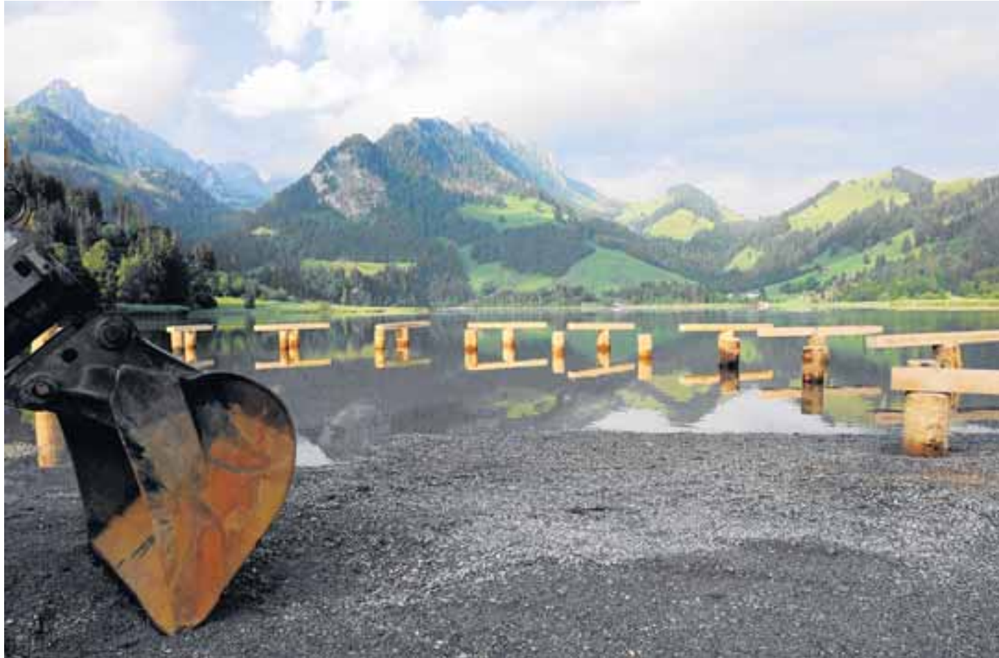
Bauarbeiten in ungewöhnlicher Umgebung: Der Badesteg wird montiert.
