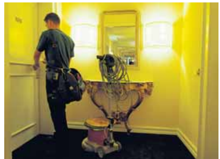
Von den 220 Zimmern sind immer einige im Umbau.
