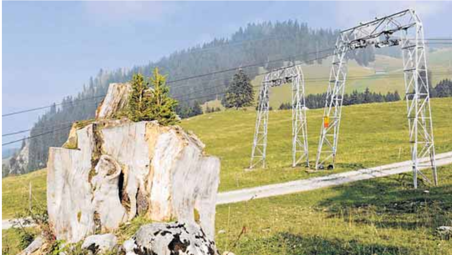
Die beiden Skilifte am Hang der Kaiseregg sollen durch eine Vierer-Sesselbahn ersetzt werden.
